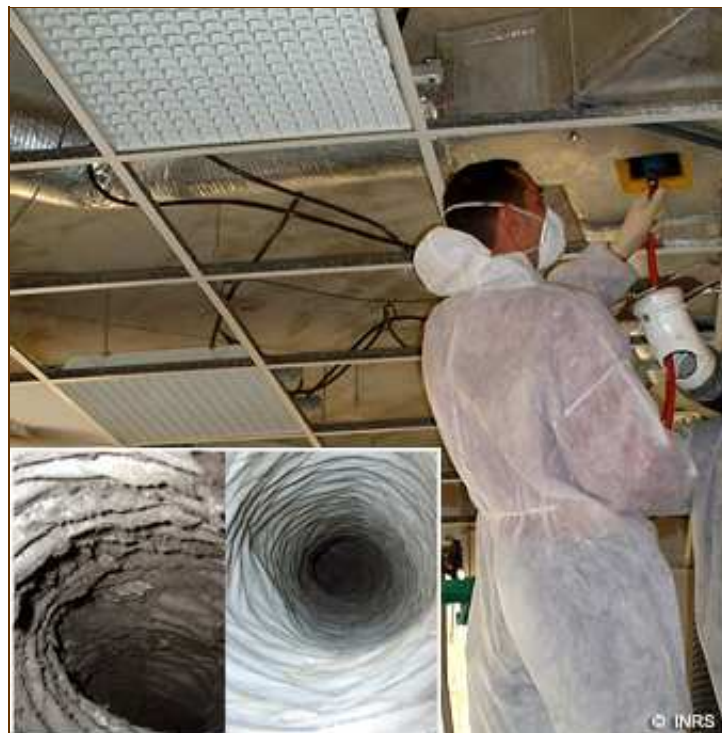
Entretien et nettoyage de gaines d'une installation de climatisation pour éviter la prolifération des agents biologiques
