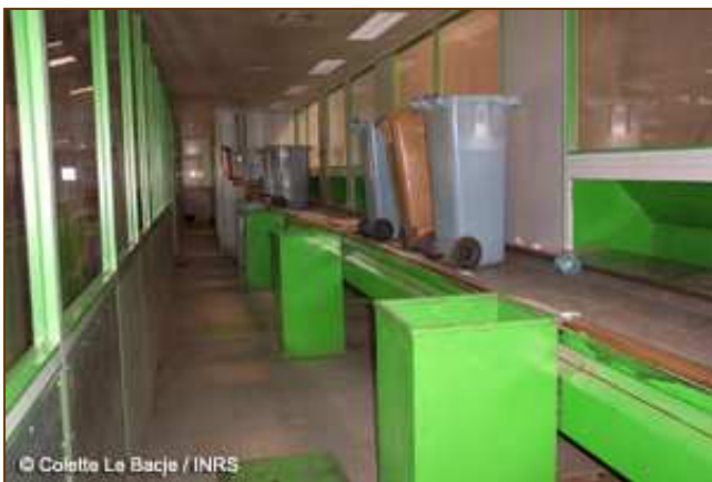
© Colette Le Bacje / INRS Assainissement de l'air des locaux de travail : cabine de tri de déchets nettoyée lors du changement d'équipe
